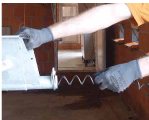
Рис. 11-10: Естественное натяжение и положение спирали
