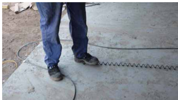
Рис. 11-3: Зафиксируйте конец спирали Рис. 11-4: Отмотайте спираль
