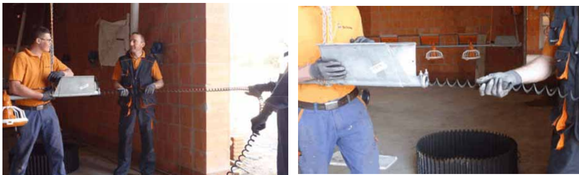
Рис. 11-7: Зафиксируйте нижнюю часть Рис. 11-8: Задвиньте спираль
