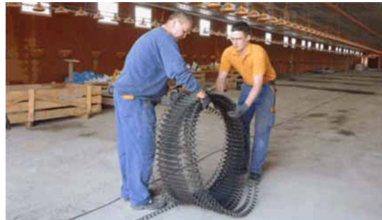
Рис. 11-3: Зафиксируйте конец спирали Рис. 11-4: Отмотайте спираль
