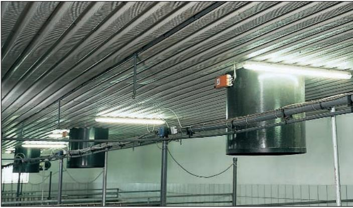
Применение осевых вентиляторов в помещении с щелевым потолком
