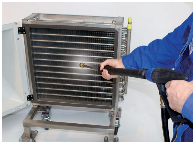
Очистка пластин с помощью очистителя высокого давления
