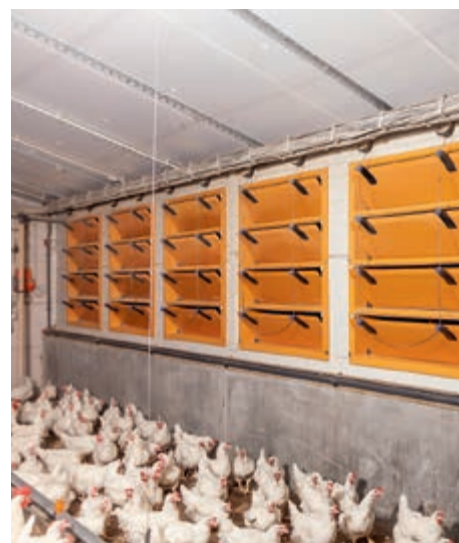
MultiVent 4 – многослойный клапан из ПУ
