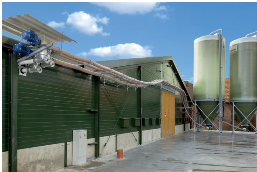
100 %-ое применение FlexVey PUR для транспортировки корма от бункера к корпусу
